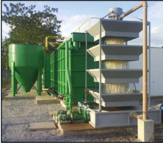
Galeao Havaalanı Fiziksel Arıtma Sistemi ve Ters Osmoz Membranları
