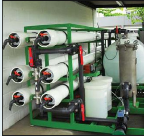
Galeao Havaalanı Fiziksel Arıtma Sistemi ve Ters Osmoz Membranları
