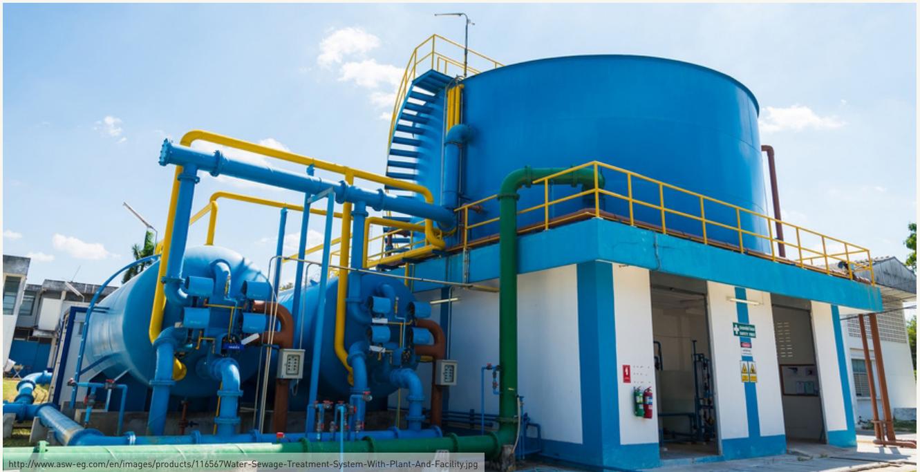
Endüstriyel Atıksu Arıtma Tesisi
