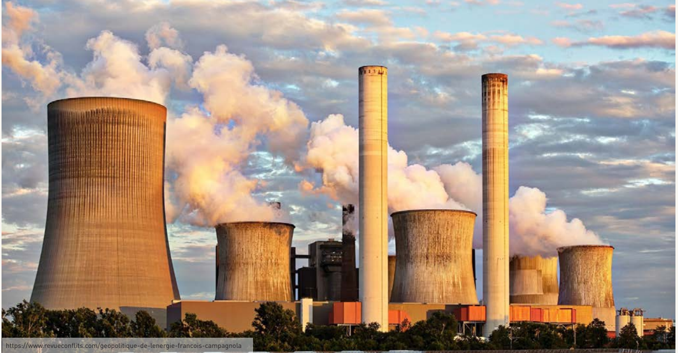
Kule Tipi Soğutma Sistemleri
