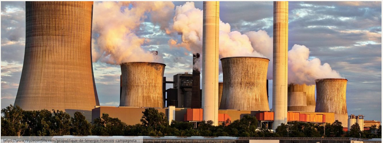
Kule Tipi Soğutma Sistemleri
