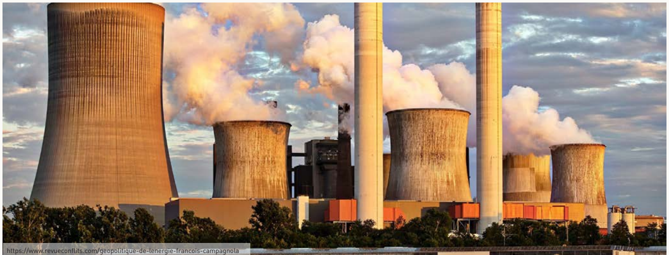
Kule Tipi Soğutma Sistemleri
