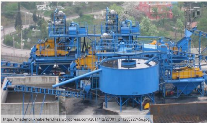
Kömür Zenginleştirme - Lavvar Tesisi
